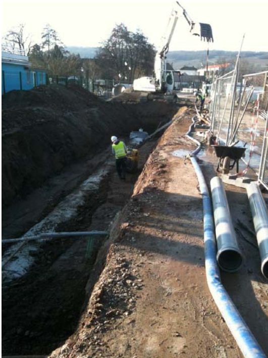
Molsheim : liaison inter quartiers pose du collecteur pluvial Ø 1500 mm
