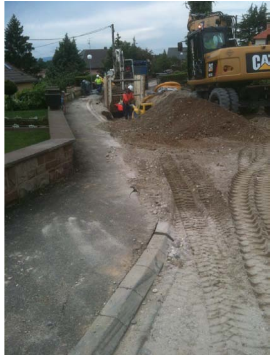
Ernolsheim-sur-Bruche : renouvellement réseau ASS - rue des Alouettes
