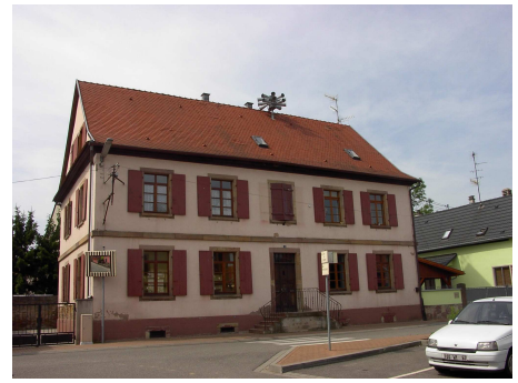
Immeuble à DUTTLENHEIM (8 logements)
