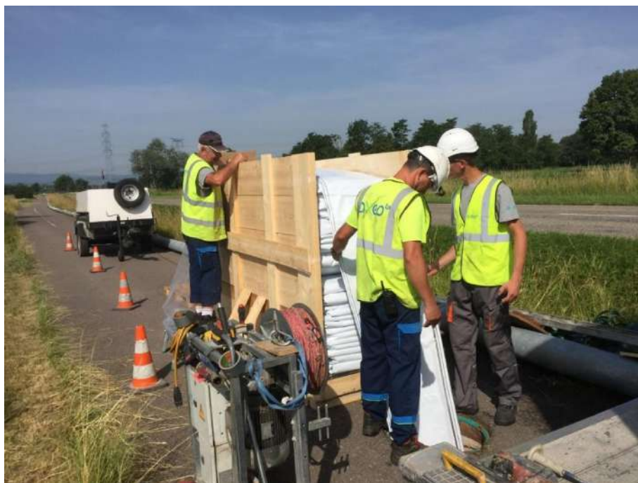
Chemisage de la conduite intercommunale d'assainissement entre Dachstein-Gare et Ernolsheim-Bruche
