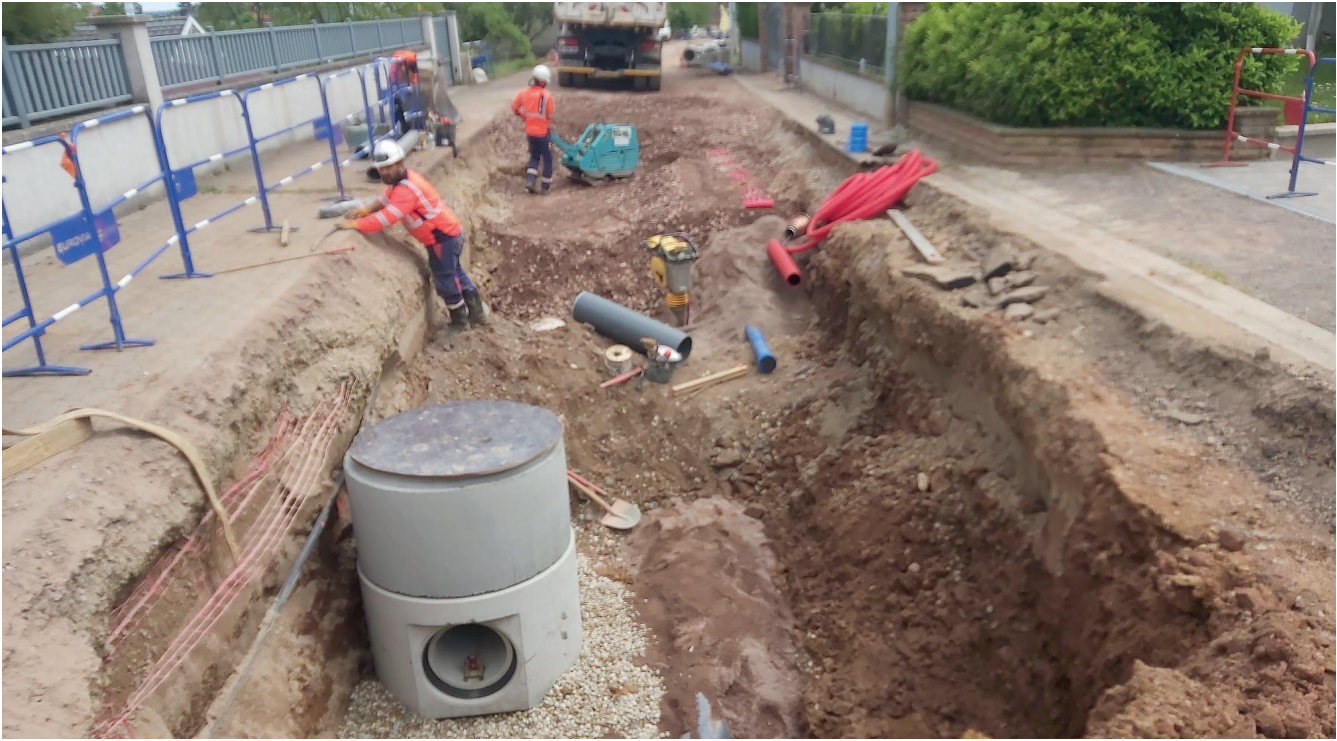
Photo du chantier rue de la Batteuse
