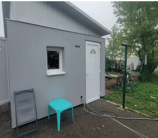
Rénovation des blocs sanitaires existants
