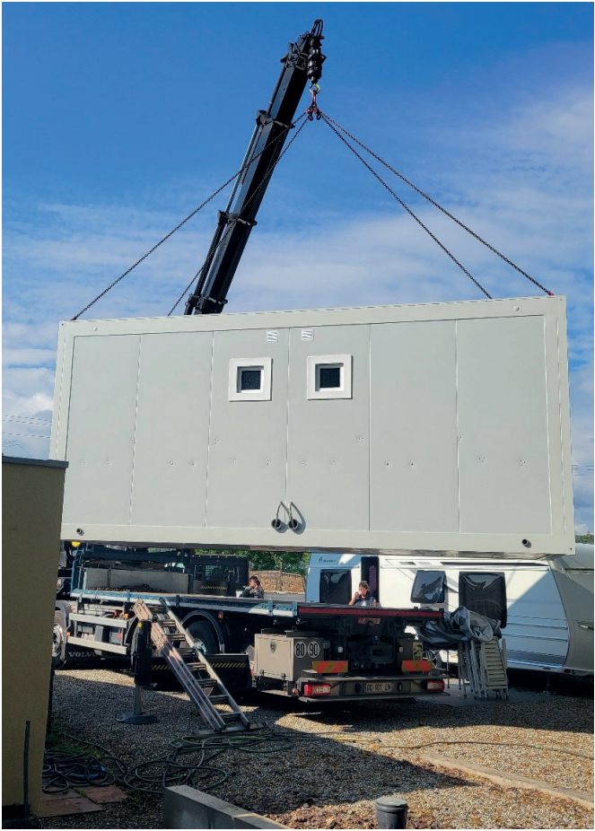
Installation d'un bungalow-sanitaire
