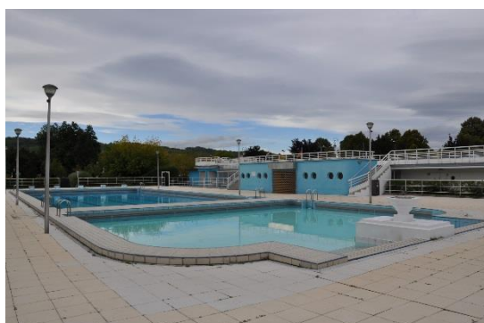
Septembre 2015 (avant travaux)
