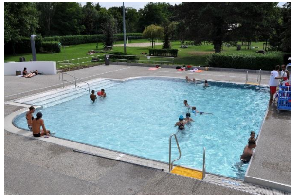
Réhabilitation du grand et petit bassin (mise en place d'un revêtement inox) et reprise des plages minérales
