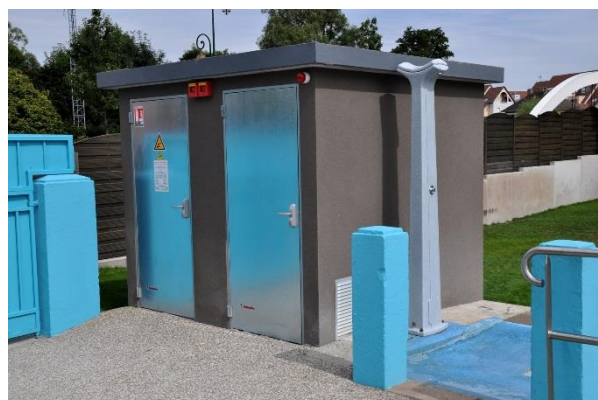
Création de locaux de stockage des produits de traitement de l'eau
