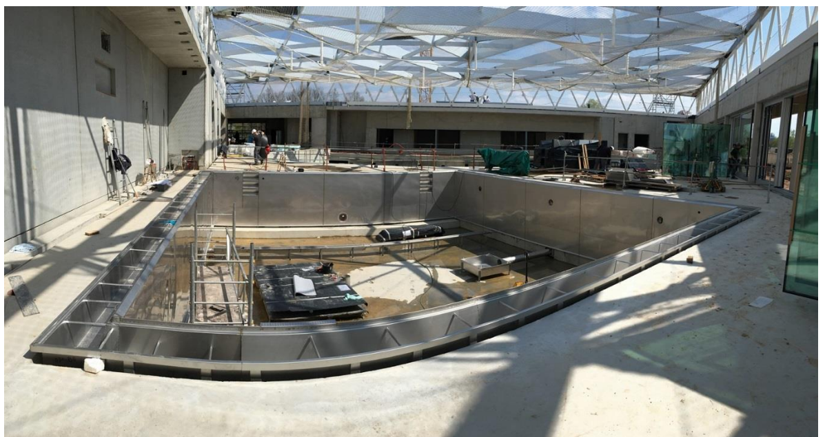
Avril 2016 : le bassin d'apprentissage et son fond mobile
