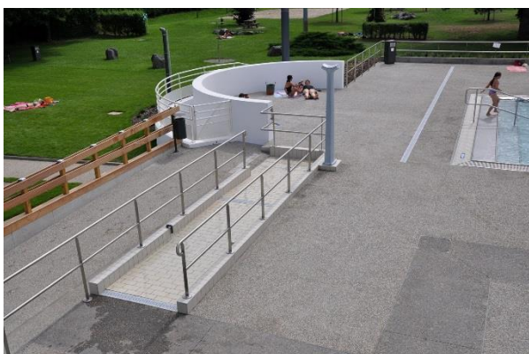
Mise en conformité des pédiluves
