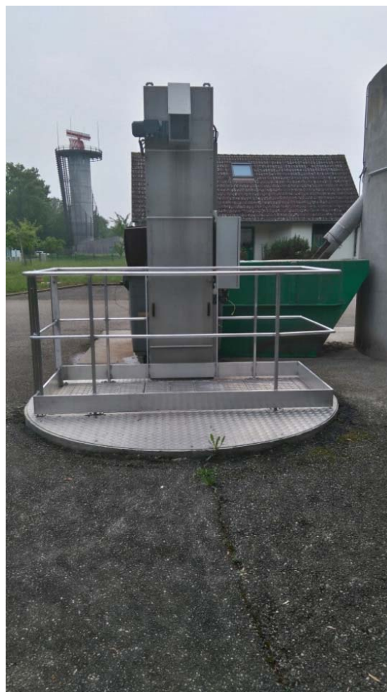
Installation d'un dégrilleur grossier et mise en conformité de l'accès au poste de relevage
