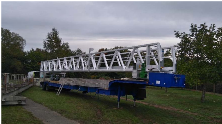
Nouveau pont clarificateur
