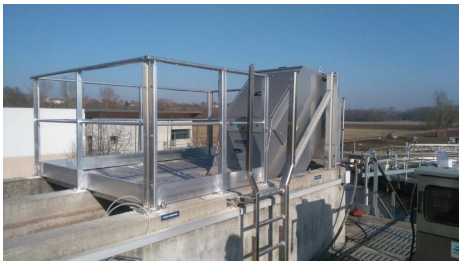
Mise en sécurité de l'accès au dégrilleur fin
