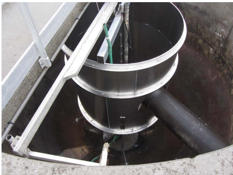
Remplacement du clifford du dégraisseur-dessableur
