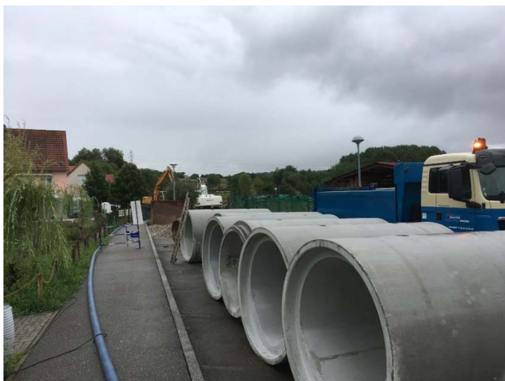
Still Assainissement Général renforcement aval rue de la Paix
