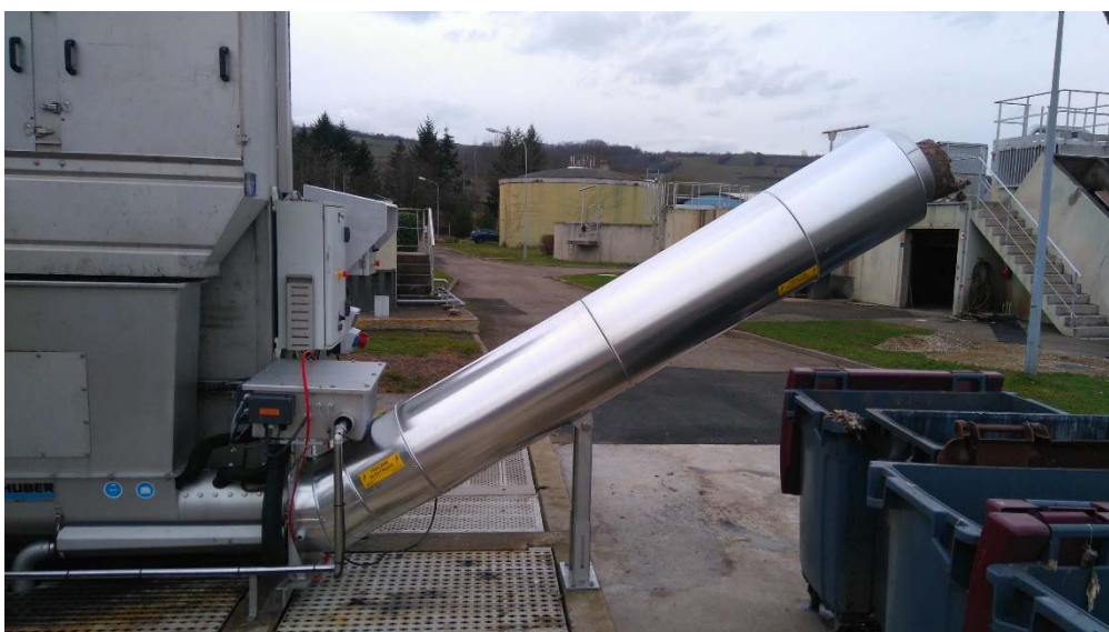
Nouveau compacteur/laveur à déchets associé au dégrilleur grossier
