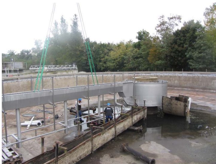
Ancien et nouveau pont clarificateur
