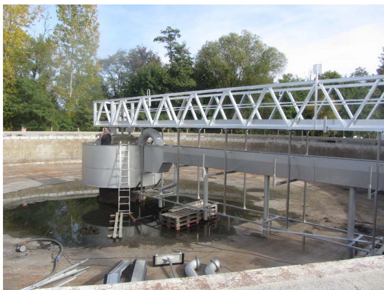
Nouveau pont clarificateur
