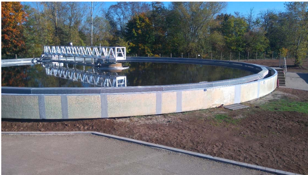
Le nouveau pont clarificateur et l'habillage du chemin de roulement
