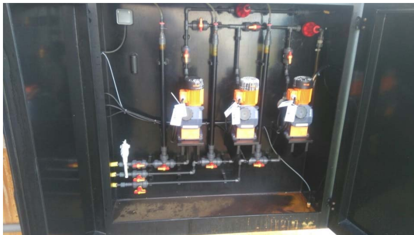
Station d'épuration d'Ernolsheim-Bruche Remplacement du coffret des pompes d'injection de chlorure ferrique
