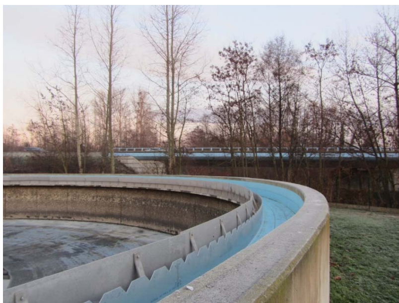
Station d'épuration de MOLSHEIM Remplacement de la paroi siphonnée du clarificateur de la nouvelle file
